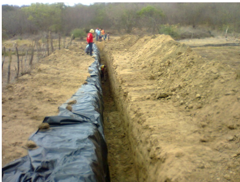
Figura 6: Colocação da lona do lado de jusante, Fonte: Oliveira et al. (2010)
