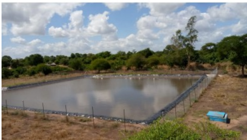
Figura 1: Reservatório escavado. Fonte: ARA_Centro, IP
