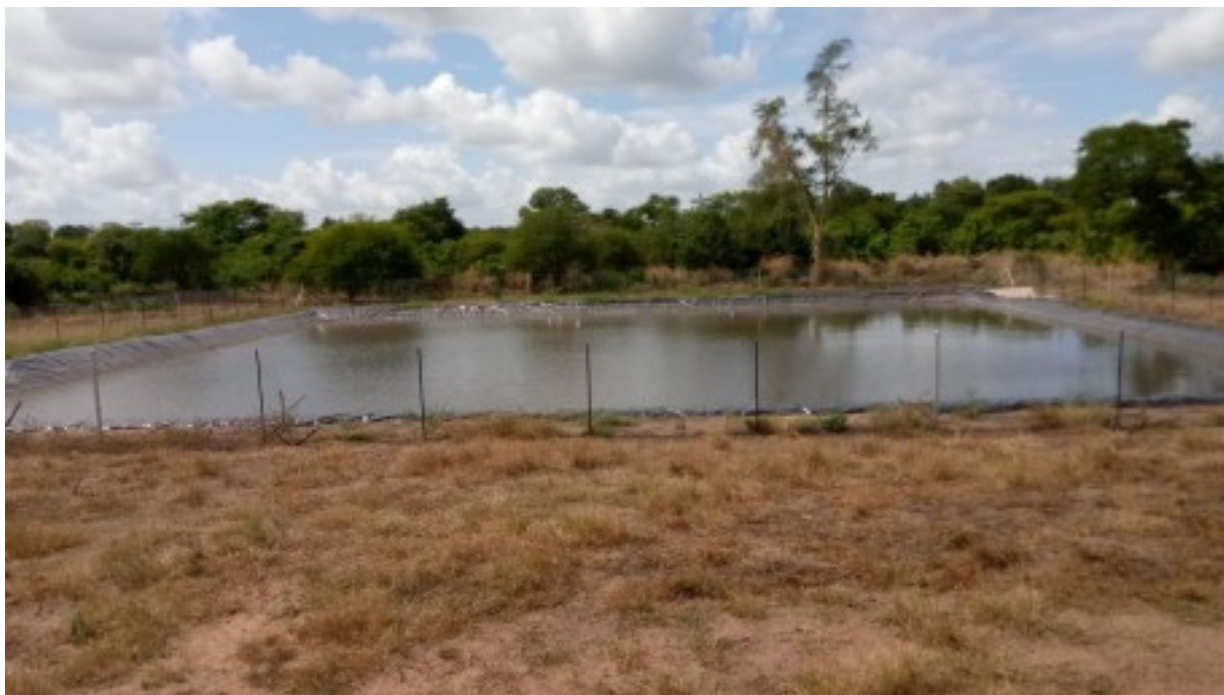
Figura 9: ANEXO DO RESERVATÓRIO ESCAVADO, FONTE: ARA_Centro, IP
