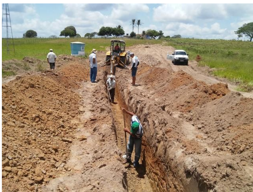
Figura 5: A escavação da vala, Fonte: Oliveira et al. (2010)
