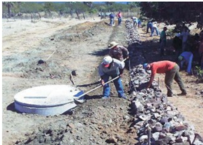
Figura 7: Possesso de aterramento da trincheira com o poço e colocação de enrocamento, Fonte: Oliveira et al. (2010).
