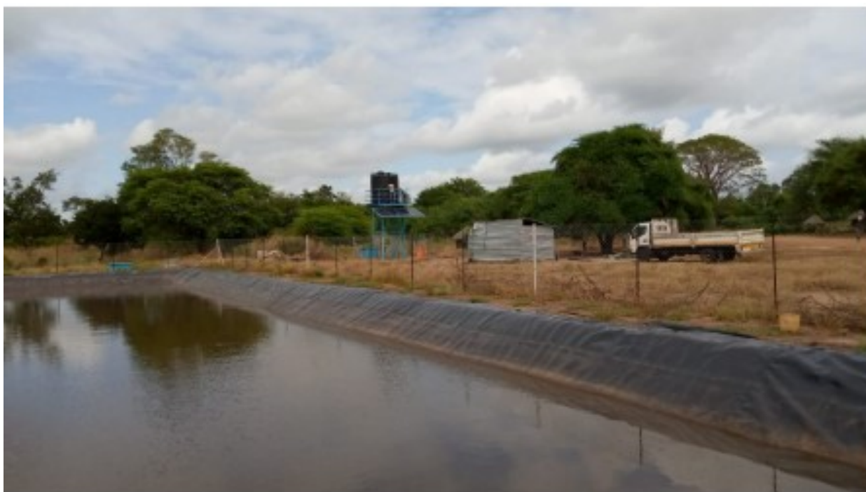
Figura 10: ANEXO DO RESERVATÓRIO ESCAVADO, FONTE: ARA_Centro, IP
