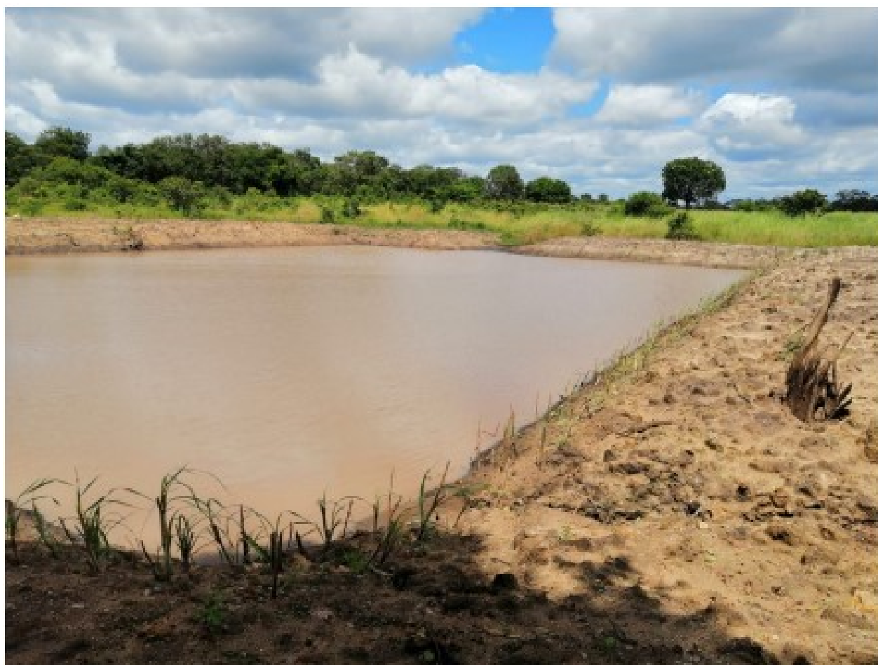
Figura 12: ANEXO DO RESERVATÓRIO ESCAVADO, FONTE: ARA_Centro, IP
